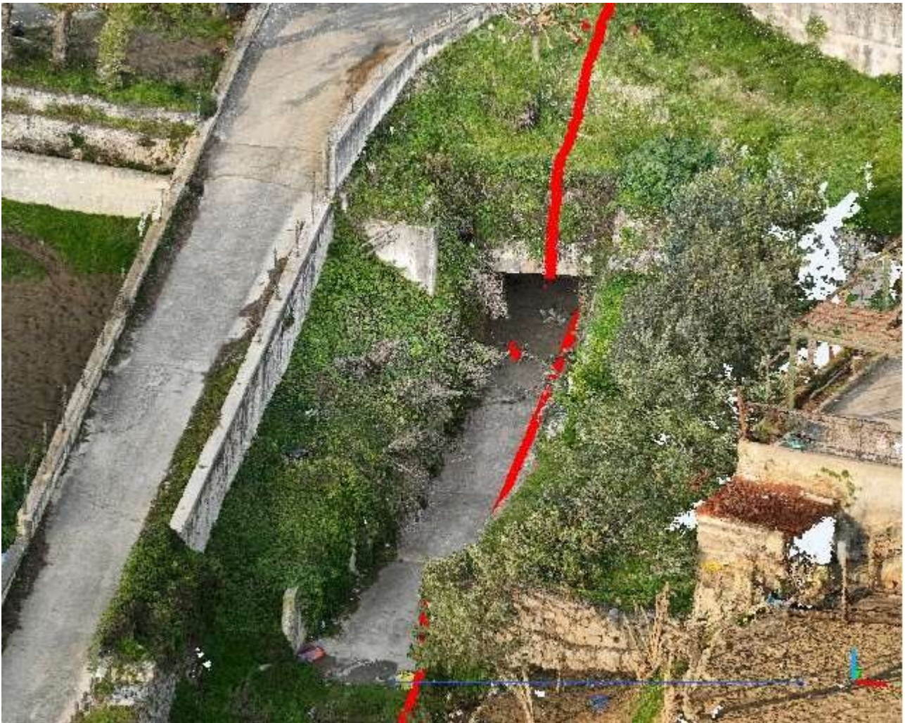
Figura 6 - sbocco del primo tratto tombato
