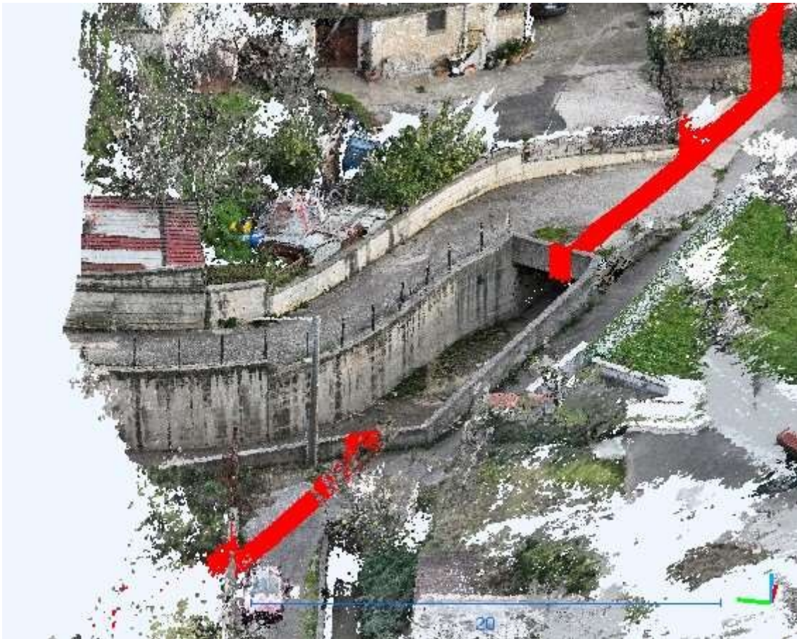
Figura 5 - Imbocco del primo tratto tombato
