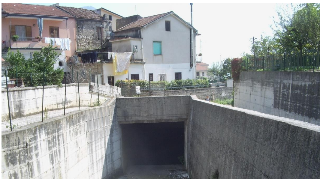
Inizio del tratto tombato del Vallone Marzio in località Santissima Annunziata.
