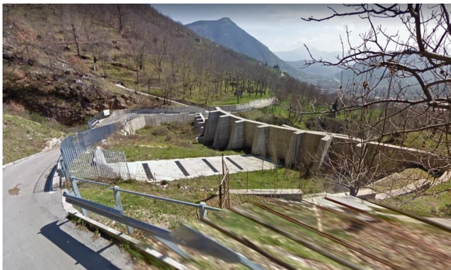
Fig. 7-2 – Opere esistenti in località Tavolara (vista da monte)
