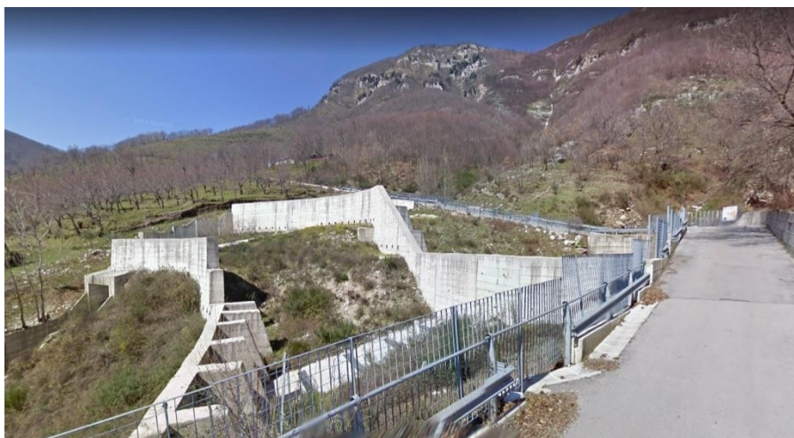
Fig. 7-1 – Opere esistenti in località Tavolara (vista da valle)
