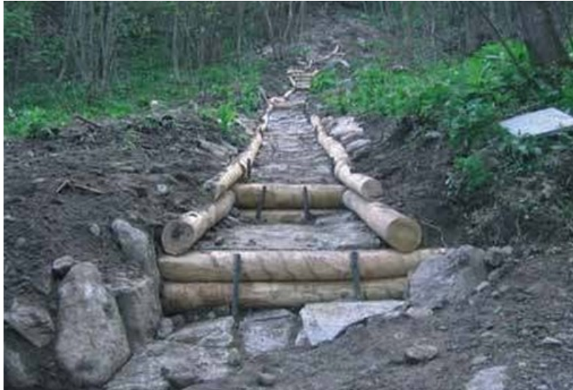
Con canalizzazione naturale in pietrame e calcestruzzo e sponde in legno
