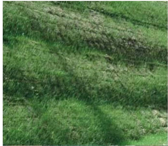
Inerbimento mediante idrosemina
