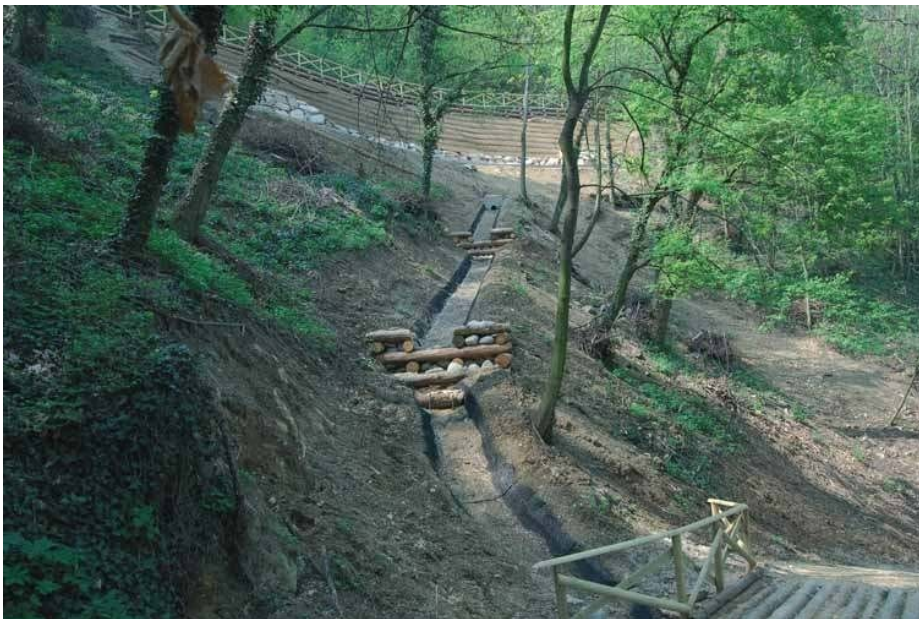
Con canalette prefabbricate
