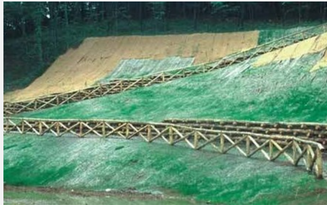
reti in fibra naturale di cocco
