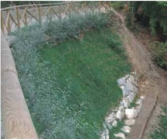
Inerbimento mediante idrosemina
