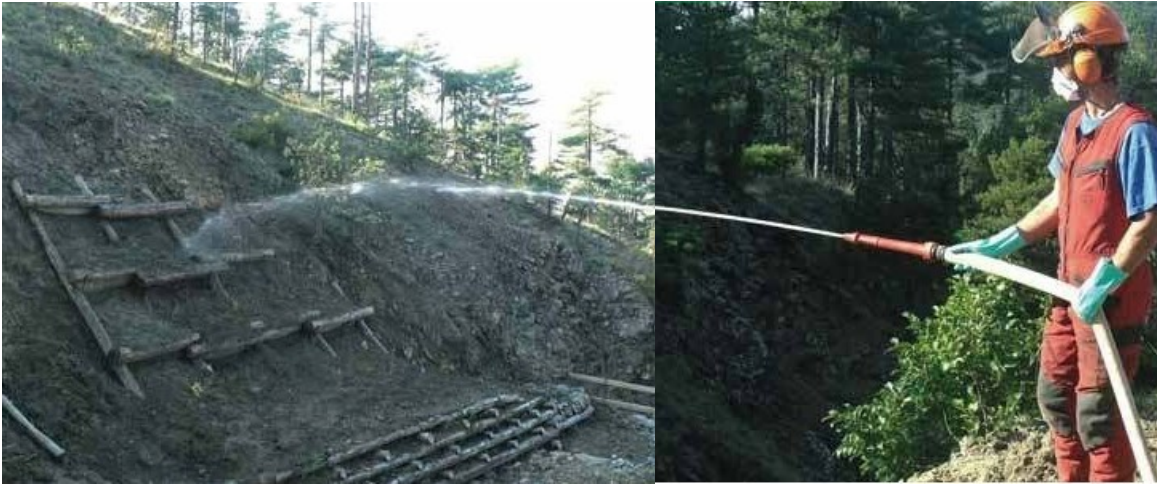
Inerbimento mediante idrosemina
