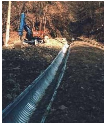
Con canalizzazione in acciaio
