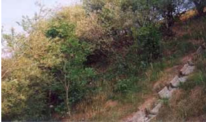
Con canalette prefabbricate
