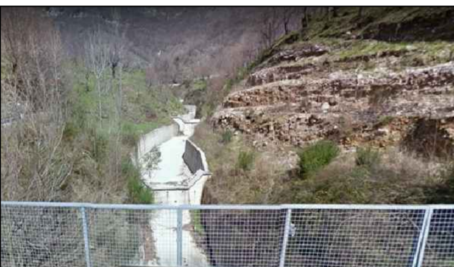
VISTA 3 Vasca 3 - Stato di fatto
