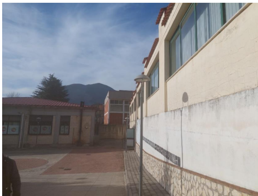
Foto 8: vista ingresso Piano interrato Istituto F.Filzi
