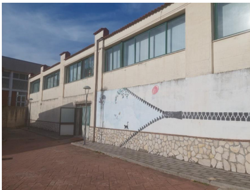
Foto 5: vista prospetto Sud - Piano Interrato Istituto F.Filzi
