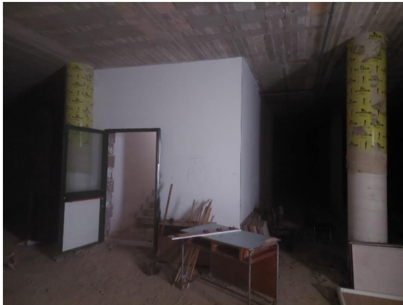
Foto 7: vista interna Piano interrato Istituto F.Filzi
